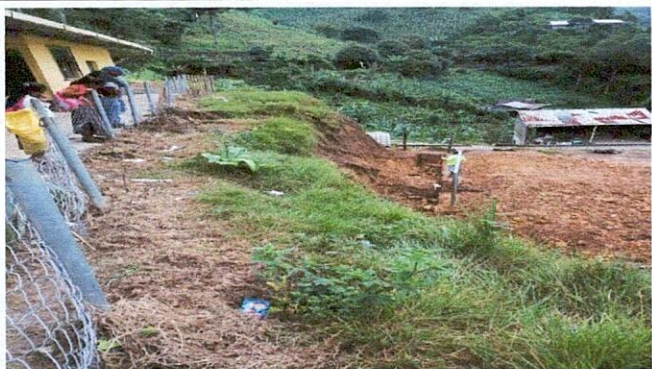
Foto1: Mejoramiento de muro - Por deslizamiento de tierra y para prevenir accidentes
