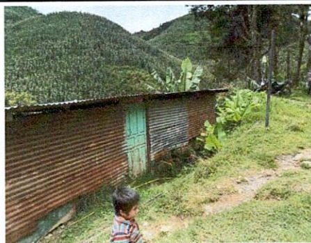
Foto 6: Mejoramiento de entechado - En las aulas existen goteras por las malas condiciones de las laminas
