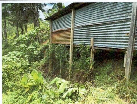
Foto 5: Mejoramiento de ventanas - no cuenta con iluminacion
